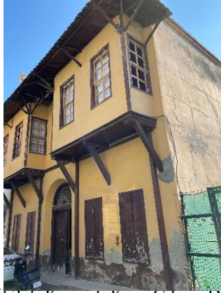
Şekil 2.3. Kemerli Kapı-Çıkma Detayı
