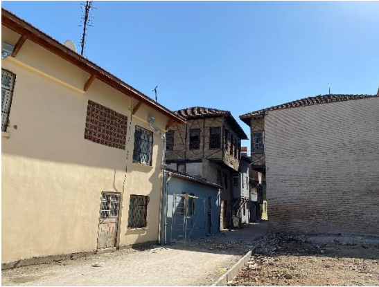
Şekil 2.19. 26012 Sokak Sağlıklaştırma Çalışmaları
